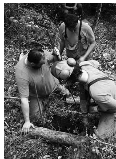
Ausbesserung des Chrüzweg durch den Zivilschutz in Untervaz
