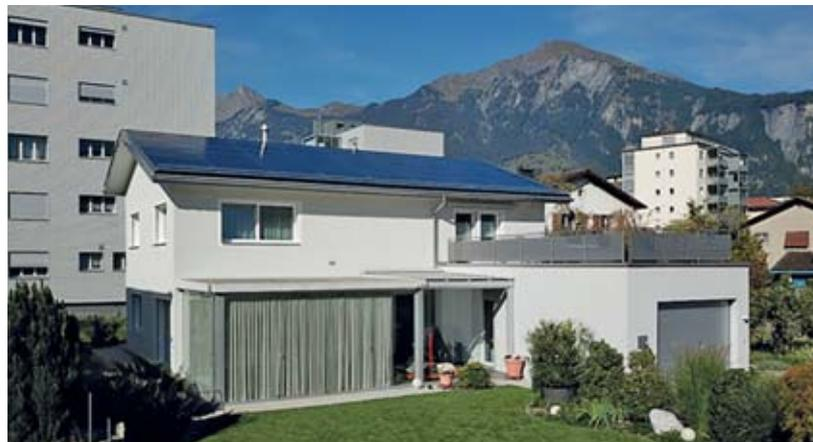
**Dieses im Minergie-P-Standard gebaute Einfamilienhaus wird mit einer Erdsonden-Wärmepumpe beheizt. Die Wärmepumpe wird mit dem Strom von der eigenen Solaranlage betrieben.**
