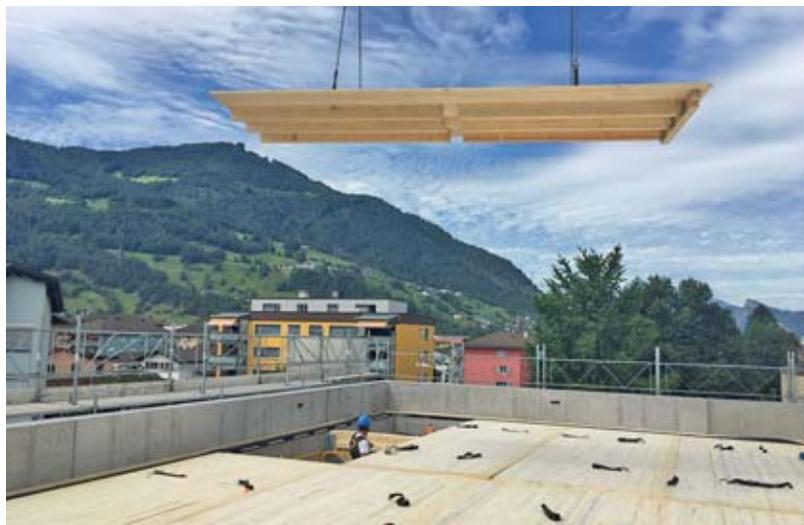
Für die Dachkonstruktion der Halle wurden insgesamt 310 m<sup>3</sup> Rundholz aus dem Landquarter Wald geschlagen. Aus diesem Rundholz wurden die benötigten 131 m<sup>3</sup> Bauholz eingeschnitten. Diese entspricht rund 56 Tonnen Holzmasse, gewonnen aus etwa 500 Stämmen mit 5 Meter Länge und 40 Zentimeter Durchmesser. Die eingesetzte Menge Bauholz bindet
