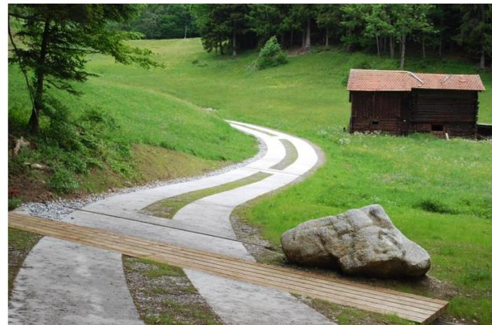
Ein natürlicher Kiesweg im flachen Gelände und funktionelle Betonspuren im Steilen.
